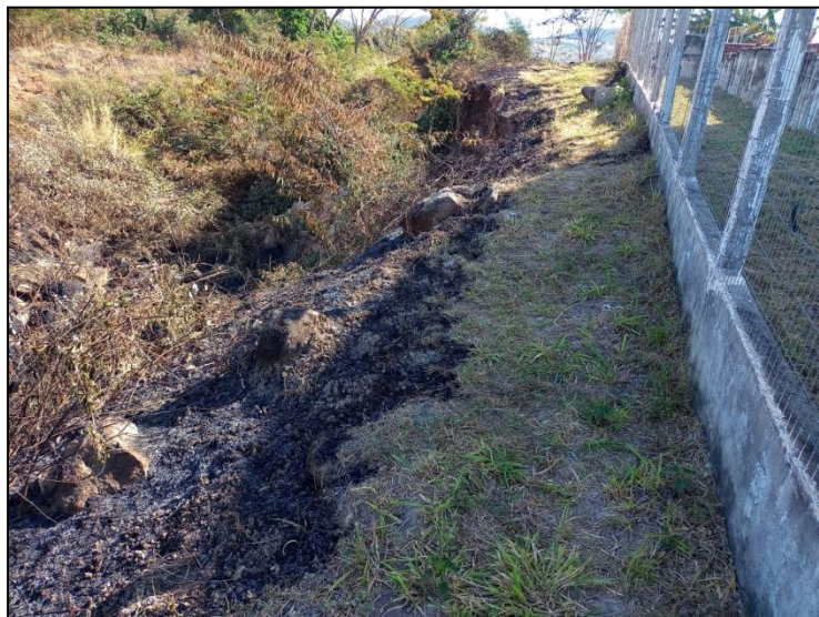
Fotografia 4 – Erosão e queimada na área do RAP.
