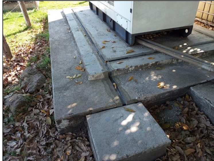
Fotografia 3 – Sistema de drenagem oleosa.
